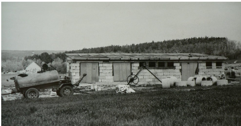
Stavba kabin, rok 1973 (zdroj Facebook, fotka z příspěvků Radima Trejby)
