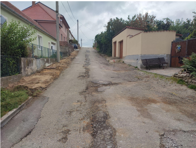
Oprava chodníků a komunikace Na Kopci
