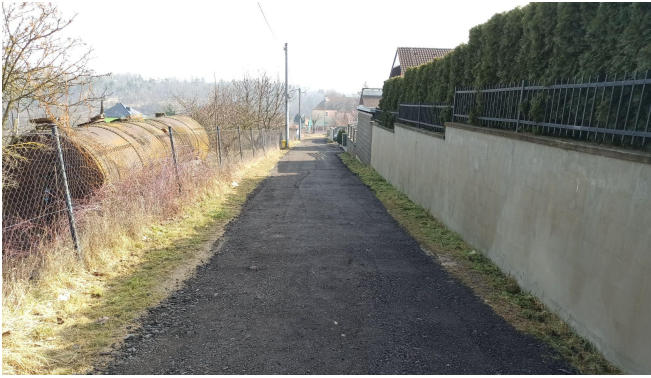
Zpevnění komunikace Za Školou
