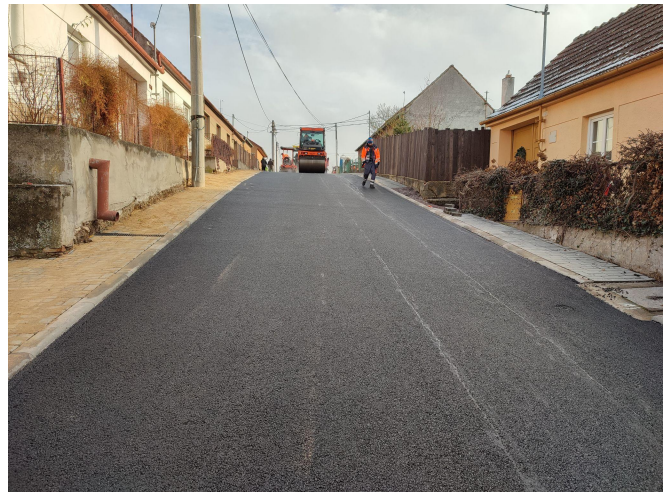
Oprava chodníků a komunikace Na Kopci
