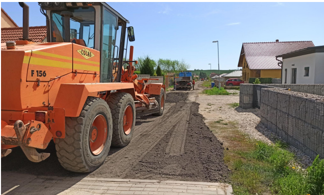
Zpevnění komunikace Na Nivách
