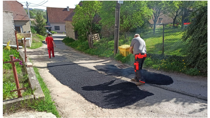
Lokální opravy asfaltem
