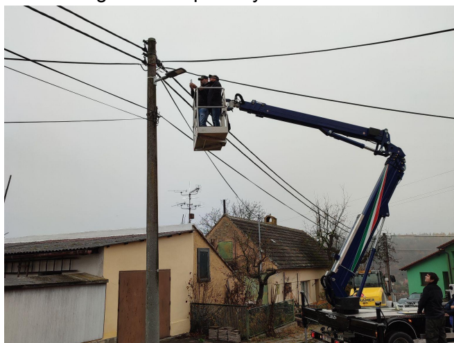
Modernizace veřejného osvětlení v obci
